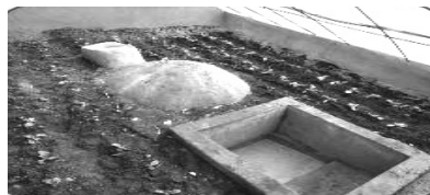
〈온실 내 메탄 발효기 설치〉
